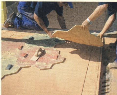
Una vez limpio y seco el pavimento realizado con **DURIMPRES REHABILITACION** tiene el mismo aspecto que un hormigón impreso, con la ventaja de que solo requiere 1,5 a 1,8 mm de espesor, lo que hace este material idóneo para la rehabilitación de pavimentos en exteriores o interiores. Finalmente puede ser protegido con **RESIMPRES D** o con **RESIMPRES A** que es la resina que se utiliza para la protección de pavimentos impresos.
