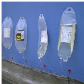
*Teais Capi-C es un sistema de inyectoros basado en resinas especiales de gran poder hidrofugante e impermeabilizante. Su gran fluidez le permite una muy buena penetración en los poros hasta una completa saturación.*
