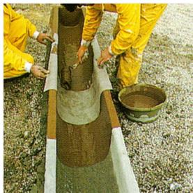
**Lastois Canalones** es un producto en base a resinas de gran elasticidad y adherencia en consistencia tipo gel, adecuado para la impermeabilización de canalones.
