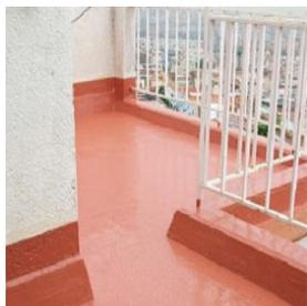
*Lastois MS Líquido es un impermeabilizante basado en polímero MS, con muy buenas propiedades impermeables, muy buena adherencia sobre diversos soportes y también en húmedo. El producto tiene rápido secado.*
