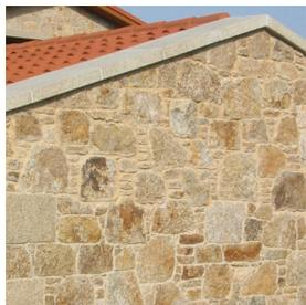
**Repais Antiverdín** es una resina a base de siloxano oligómero de baja molecularidad, que facilita su penetración en el interior del soporte sin dejar residuo ni brillo en la superficie, logrando su hidrofugación, sin inhibir la transpiración del material ni permitir la disolución de sales solubles, actuando como hidrofugante integral, al mismo tiempo que protege de la formación de verdín en las superficies sobre las que se aplica.
