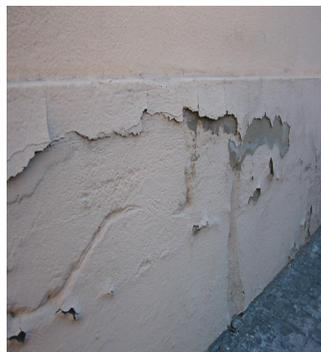
**Teais Capi C** es un sistema de inyecciones que se colocan en los muros afectados de humedades de capilaridad. El sistema consiste en la realización de perforaciones con taladro en el muro en las cuales se colocan los inyectores. El líquido inyectado tiene alta penetración y cura en medios húmedos formando una barrera que impide el acceso de la capilaridad en los paramentos. El sistema permite reparaciones en muros de piedra, hormigón, ladrillo hueco y macizo.
