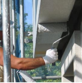
*Lastois Capa Intermedia es un producto a base de resinas elastoméricas, aditivos y pigmentos de alta resistencia al agua, de fácil aplicación por ser monocomponente y muy eficaz como impermeabilizante.*
