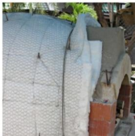
Los módulos de fibra cerámica son producidos mediante colcha cerámica comprimida. Son especialmente diseñados para cumplir y mejorar requerimientos de aislamiento térmico para hornos industriales y algunas otras aplicaciones.
