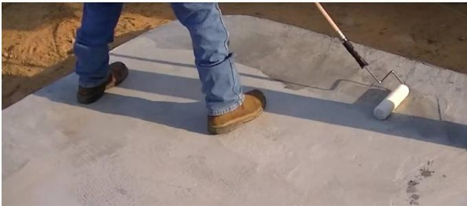
Aplicación de impridur sobre solera con barrera de vapor
