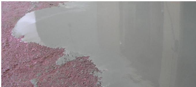
Aplicación de durepox autonivelante en solera sin barrera de vapor
