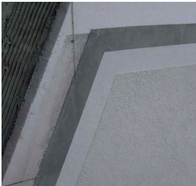
Colocación de capa de consolidación y armado
