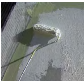
Aplicación de capa de imprimación con IMPRILAIS
