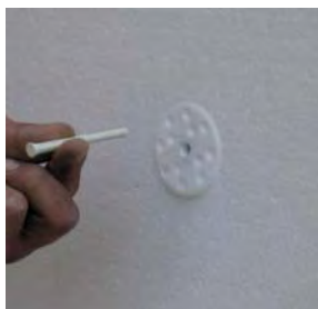
Colocación de fijaciones mecánicas FIJOPLAST
