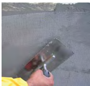
Colocación de capa de consolidación y armado
