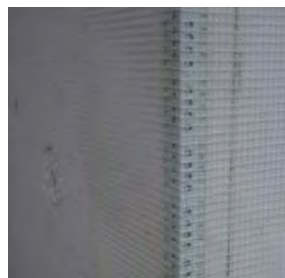
Colocación de cantonera en esquina para refuerzo mecánico
