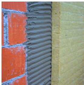
**Peganel** es un adhesivo cementoso con propiedades impermeables especial para la colocación de paneles de aislamiento en base a lana de vidrio u otras lanas minerales.
