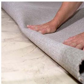
**Contactis Aqua** es un adhesivo de contacto al agua para el pegado sobre diversos tipos de soportes, tanto absorbentes como no absorbentes. Se aplica mediante llana de dientes finos sobre ambas caras de los elementos a pegar. Se deja orear y se presiona hasta que el adhesivo se seque.
