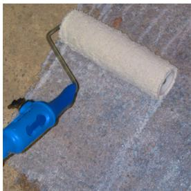
*Unirres-NC universal es una resina basada en polímeros que se utiliza para mejorar la adherencia de morteros sobre superficies metálicas, de madera, de poliestireno, etc. Sin inducir procesos corrosivos.*
