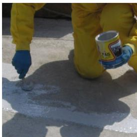
**Epoais 10** es un adhesivo a base de resinas epoxi, se presenta en dos componentes que se mezclan antes de su utilización. Tiene una viscosidad adecuada para permitir la aplicación a modo de pintura, tanto en superficies verticales como horizontales.
