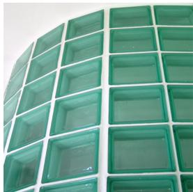
**Morvi** es un mortero que se presenta en polvo para preparar con agua. El producto está formulado a base de cemento modificado con resinas especiales y áridos finos especialmente seleccionados. Una vez amasado con agua, es una pasta tixotrópica, ideal para la colocación de pavés de vidrio.
