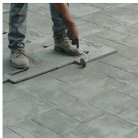
*Durimprés Rehabilitación es un mortero especial basado en ligantes cementosos, áridos de cuarzo, pigmentos, y aditivos especiales.*
