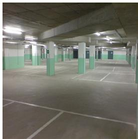
*Tradur es un producto sólido, en polvo y grano, que espolvoreado sobre la superficie de soleras de hormigón en el momento de su construcción le proporciona un considerable aumento de dureza a la rodadura, está formulado en base a áridos de cuarzo seleccionados, ligantes especiales, aditivos y pigmentos.*
