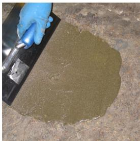
*Durepox Tixotrópico es un mortero de consistencia tixotrópica en base a resinas epoxi y cargas especiales, reforzado con polipropileno. De alta resistencia mecánica y rápida puesta en servicio.*
