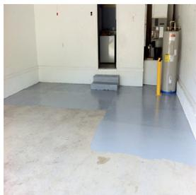
***Epoais D** es una pintura de dos componentes a base de resinas epoxi y pigmentos inocuos. Cumple la norma UNE-53550 sobre migración global de residuo en el medio (< 10 mg/dm<sup>2</sup>) siendo apto para el contacto con alimentos.*
