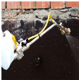
*Brepois es un alquitrán epoxi en dos componentes, que una vez mezclado en la proporción 10A/1B en peso, permite aplicar el producto en capa gruesa sin que descuelgue (máximo 150 micras por mano de película húmeda).*
