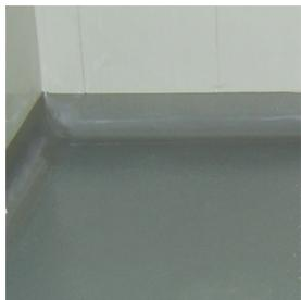
***Epox Aqua** es una pintura revestimiento de olor suave a base de resina epoxi y agua como diluyente lo que permite su aplicación en superficies en contacto con líquidos sin alternar sus propiedades ni sabor.*
