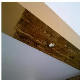
*Imade es una pintura de efecto especial basada en resinas acrílicas al disolvente, con pigmentos que permiten dar efecto de vetas de madera.*
