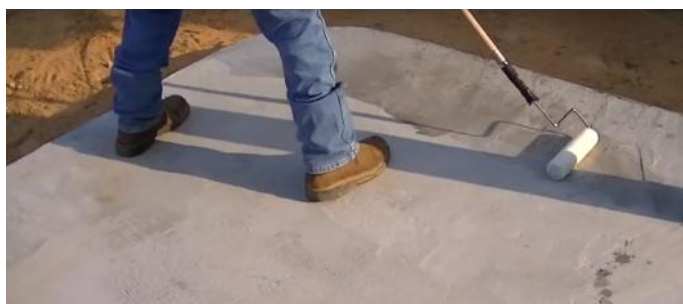
Application d'impridur sur dalle avec barrière de vapeur
