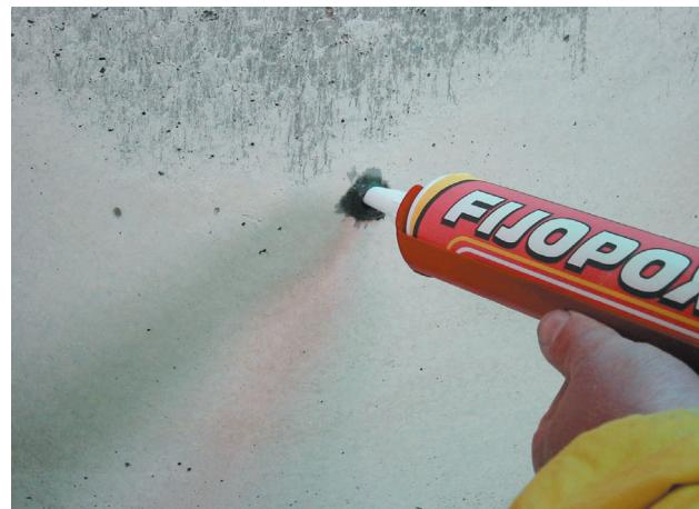
**FIJOPOX** es una masilla de dos componentes en base a resina epoxi, la mezcla de los dos componentes se realiza en el pico mezclador durante el extrusión de la masilla.
