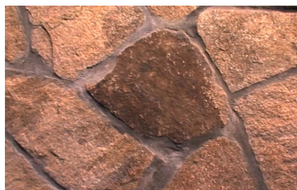
Jointoiement de pierre
