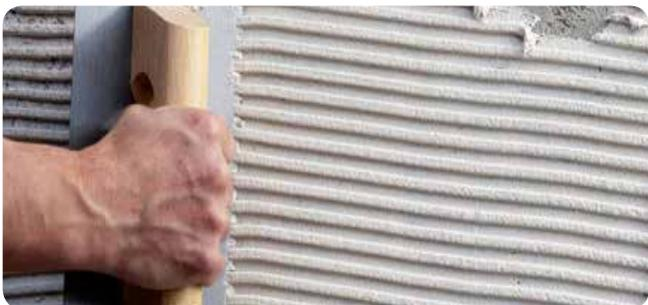
Siempre es necesario la colocación con llana dentada en toda la superficie del soporte.
