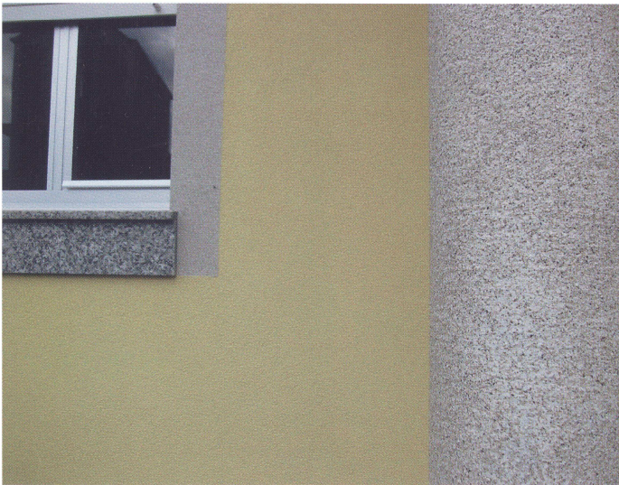
Detalle de aplicación de Rocais Artístico en recercado de ventanas
