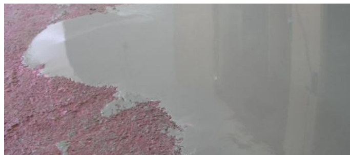
Application de durepox autonivelante sur sol sans barrière de vapeur
