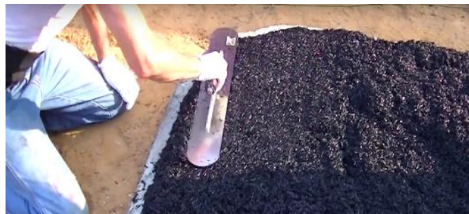
Application de durepox autonivelante sur sol sans barrière de vapeur
