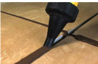
Jointoiement de brique et carreaux
