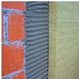
*Peganel est un adhésif cimenteux avec des propriétés hydrofuges. Formulé notamment pour la pose de panneaux d'isolation thermique à base de laine de verre ou autres laines minérales.*
