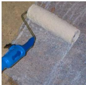
*Unirres-NC* universel UNIRRES NC est une résine à base de polymères qui s'utilise pour améliorer l'adhérence de mortiers sur surfaces métalliques, de bois, mortiers, peintures, etc. Sans produire de corrosion.
