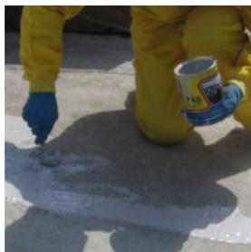
*Epoais 10 est un adhésif à base de résines époxy. Ce produit est composé de deux composants à mélanger avant son utilisation. Le produit contient une viscosité appropriée pour appliquer le produit comme peinture, sur les superficies verticales et horizontales.*
