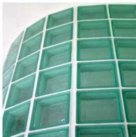
*Morvi est un mortier en poudre à mélanger avec de l'eau. Ce mortier est formulé à base de ciment, de résines spéciales et d'agrégats fins sélectionnés. Le mélange donne lieu à une pâte thixotrope utilisée pour la pose de briques de verre.*
