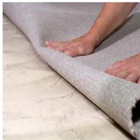
**Contactis Aqua** est un adhésif de contact à base de copolymères, adjuvants spéciaux et charges micronisés, spécialement développé pour le collage d'éléments légers et de faible absorption. Appliquer au pinceau, taloche de dents fins sur chaque côté. Laisser sécher et appuyer jusqu'à que l'adhésif sèche.
