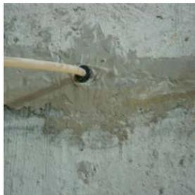
*Epoais Iny est un adhésif époxy hautement fluide. Ce produit durci sans retrait et atteint une haute résistance mécanique.*
