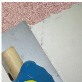
*Teais alisador monocapa est un mortier spécialement développé pour lisser les mortiers monocouches de finition gratté ou rustique, et pouvoir peindre par la suite.*
