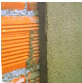
**Capilais** est un mortier spécial à base de ciment, arides sélectionnés et agents aérants, développés pour assainir les façades ou murs affectés par l'humidité par capillarité, aussi bien pour l'intérieur que pour l'extérieur.
