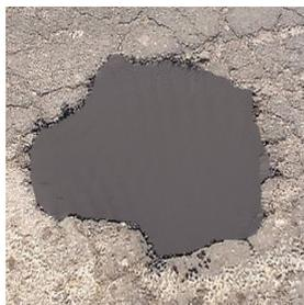
*Duroasfalt est un microbéton de séchage rapide et de résistance adéquate, formé par des liants cimenteux, fibres, et arides de granulométrie compensés, de pigment noir.*
