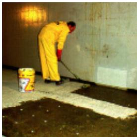
*Impridur est un scellant-réparateur de dureté superficielle à base de résine epoxy, conçu pour durcir les sols présentant des déficiences de microfissuration, de formations de crevasses, etc. Ainsi c'est un primaire pour revêtement à base d'epoxy, de polyuréthane et epoxy-polyuréthane.*
