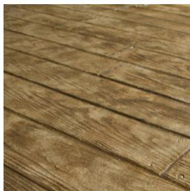
*Imade est une peinture à base de résines synthétiques qui s'appliquent sur supports minéraux comme les bétons et mortiers, permet de fournir un aspect similaire au bois.*
