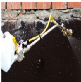
*Brepolis est un goudron époxy bi-composant, qui une fois mélangé en proportion de 10A/1B en poids, permet une application du produit en couche épaisse sans décrochage (max 150 microns par couche de pellicule humide)*
