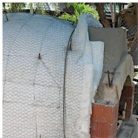
Les modules de fibre de céramique sont produits par une couverture en céramique comprimé. Spécialement développé pour améliorer l'isolation thermique des fours industriels et autres applications.
