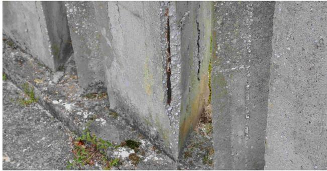
L'humidité par capillarité sur les structures de béton armé, se manifeste habituellement dans les éléments en contact avec le terrain.
