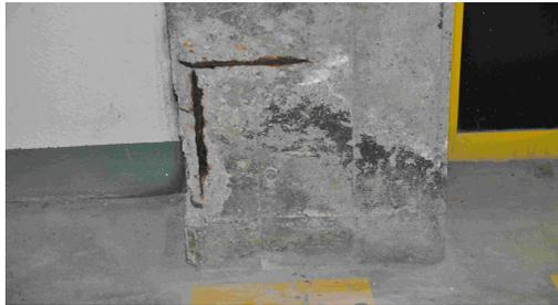
Le nettoyage de l'oxyde des armatures se réalise au moyen d'un sablage de silicate d'aluminium, pistolet à aiguille ou brosse de fer
