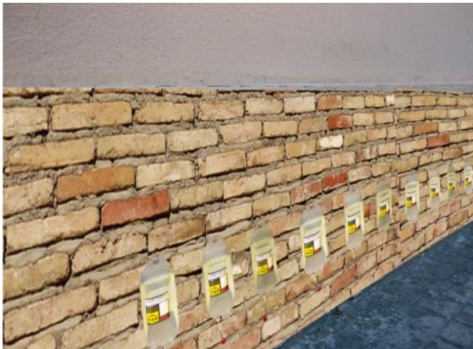
Pose sur parpaing
