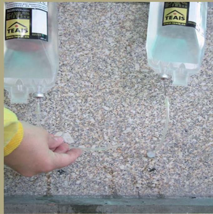
Aplicación de Sistema Teais Capi-C en interiores
